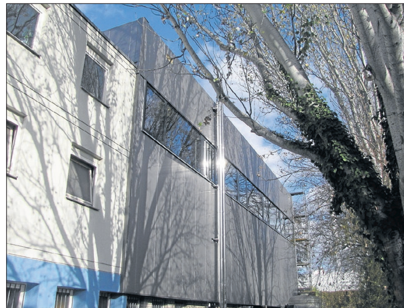
Auch die Fassade des Vereinsbades vom SV Cannstatt strahlt in neuem Glanz. Ende des Jahres startet der Badebetrieb.
