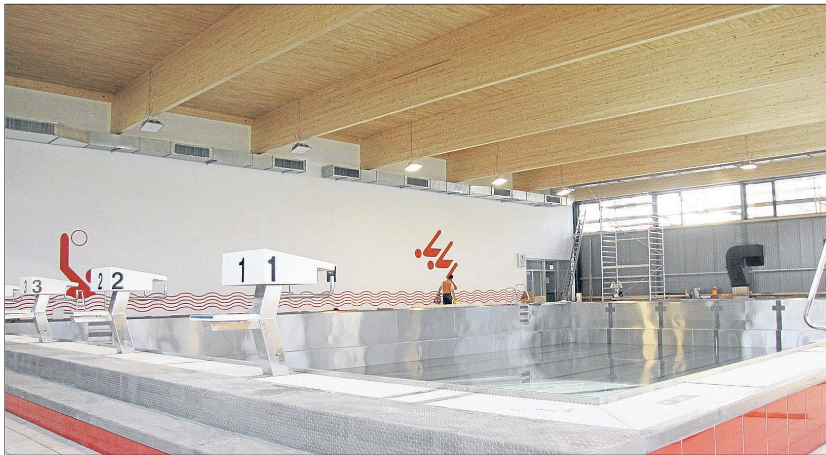
Die Arbeiten für die Sanierung des Mombach-Bades liegen im Kosten- und Zeitplan. Es gab ein neues Dach, neue Lüftung und neue Fenster. Dämmung und Beleuchtung wurden erneuert. Fotos: Rehberger
